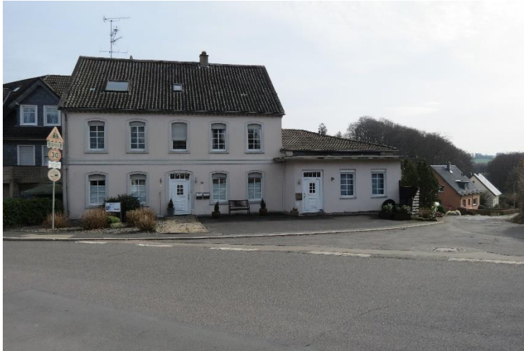
Abbildung 1 + 1: Bestandgebäude Vorder- und Rückseite
