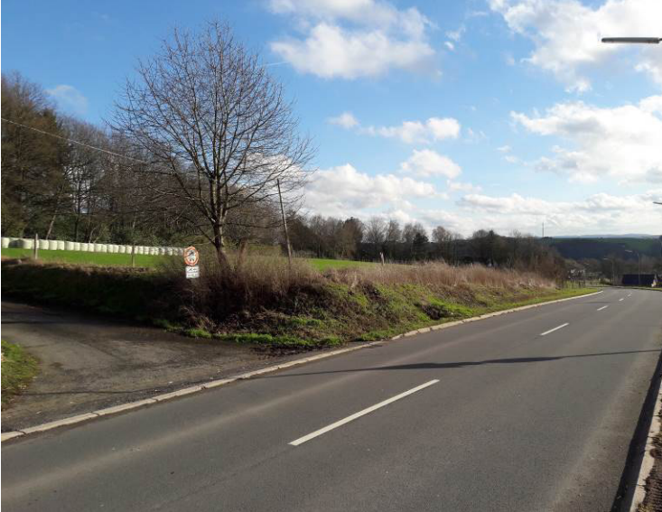
Abb. 3: Plangebiet mit Einmündung des Forstweges in die K 30 in südöstlicher Blickrichtung
