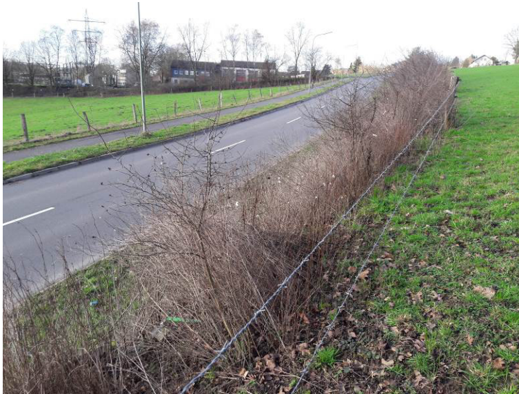
Abb. 6 Bergstraße mit Seitenstreifen und Böschung in nordwestlicher Blickrichtung
