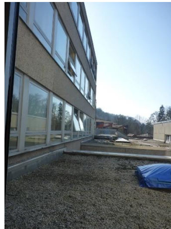
Abbildung 22: Blick aus 1 OG. Geb. H, Geb. H (links), Aula (rechts)
