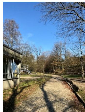
Abbildung 32: Blick von Süden auf Weg auf der Hinterseite Geb. H (links), hinterseitige Außen-treppe von Geb. N im (Hintergrund)
