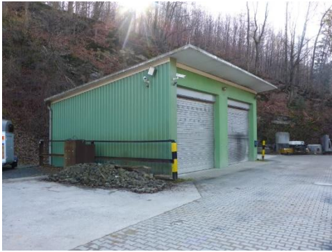
Abbildung 33: Blick von Norden auf Baugerätehalle (Tiefbau Lemm)
