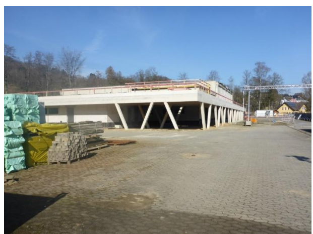
Abbildung 18: Blick von Süden auf MZH (B-Bau)
