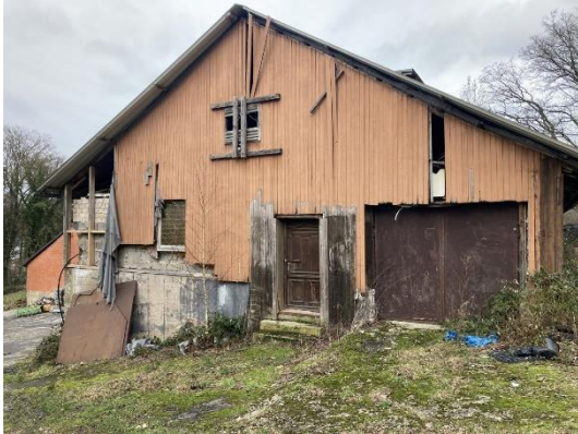
Abb. 12 Lagerhalle im Plangebiet.
