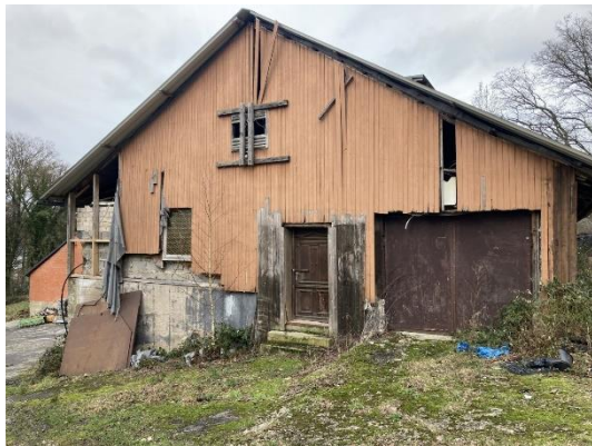
Abb. 7 Lagerhalle im Plangebiet.
