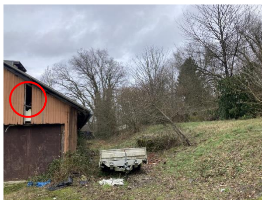
Abb. 12 Zugang zum Gebäude im Bereich der Holzverkleidung (roter Kreis).
