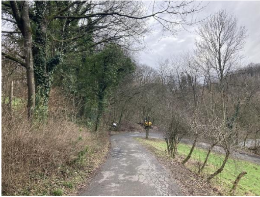
Abb. 4 Zufahrt im Plangebiet.
