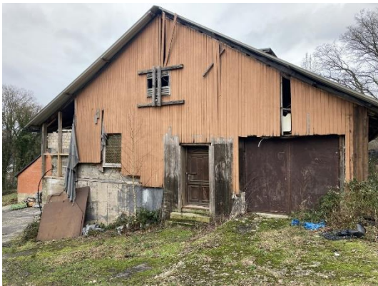
Abb. 6 Lagerhalle im Plangebiet.
