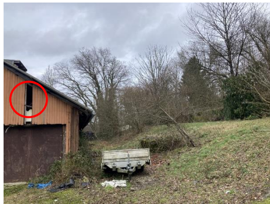
Abb. 11 Zugang zum Gebäude im Bereich der Holzverkleidung (roter Kreis).
